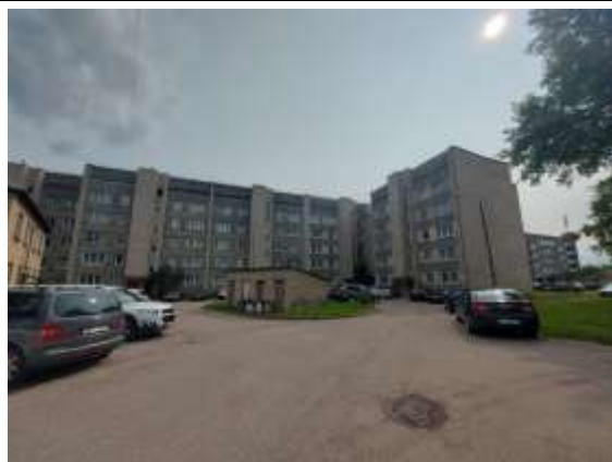
Dzīvojamā māja Augstā ielā 8
