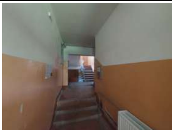
1.stāva kāpņu telpa
