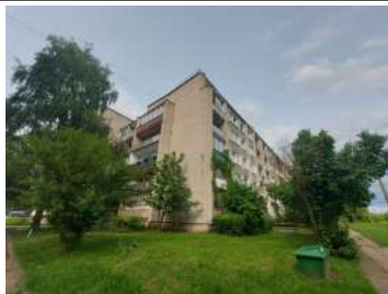
Dzīvojamā māja Augstā ielā 8
